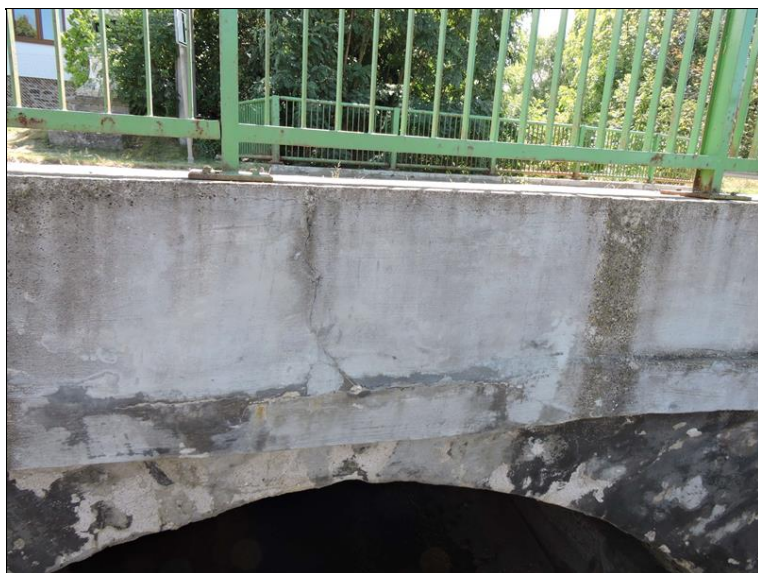
Levá mostní římsa - svislá trhlina
