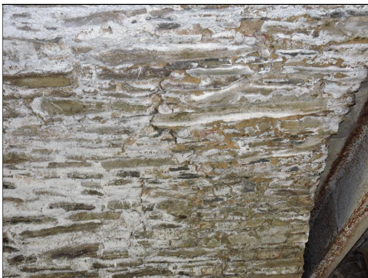
Podélná trhлина na pravé povodní straně klenby.
